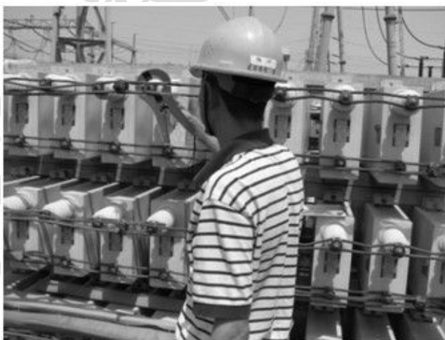
图 4 仪器现场测量实例
